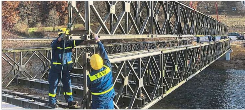
Die oberen Längsträger der Behelfsbrücke wurden in Position gehoben und anschließend per Hand befestigt. Fotos: THW Eichstätt
