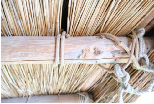
Abb. 8 | Waldrebe-Bindung an Reetdach (Schilf), bronzezeitlich
