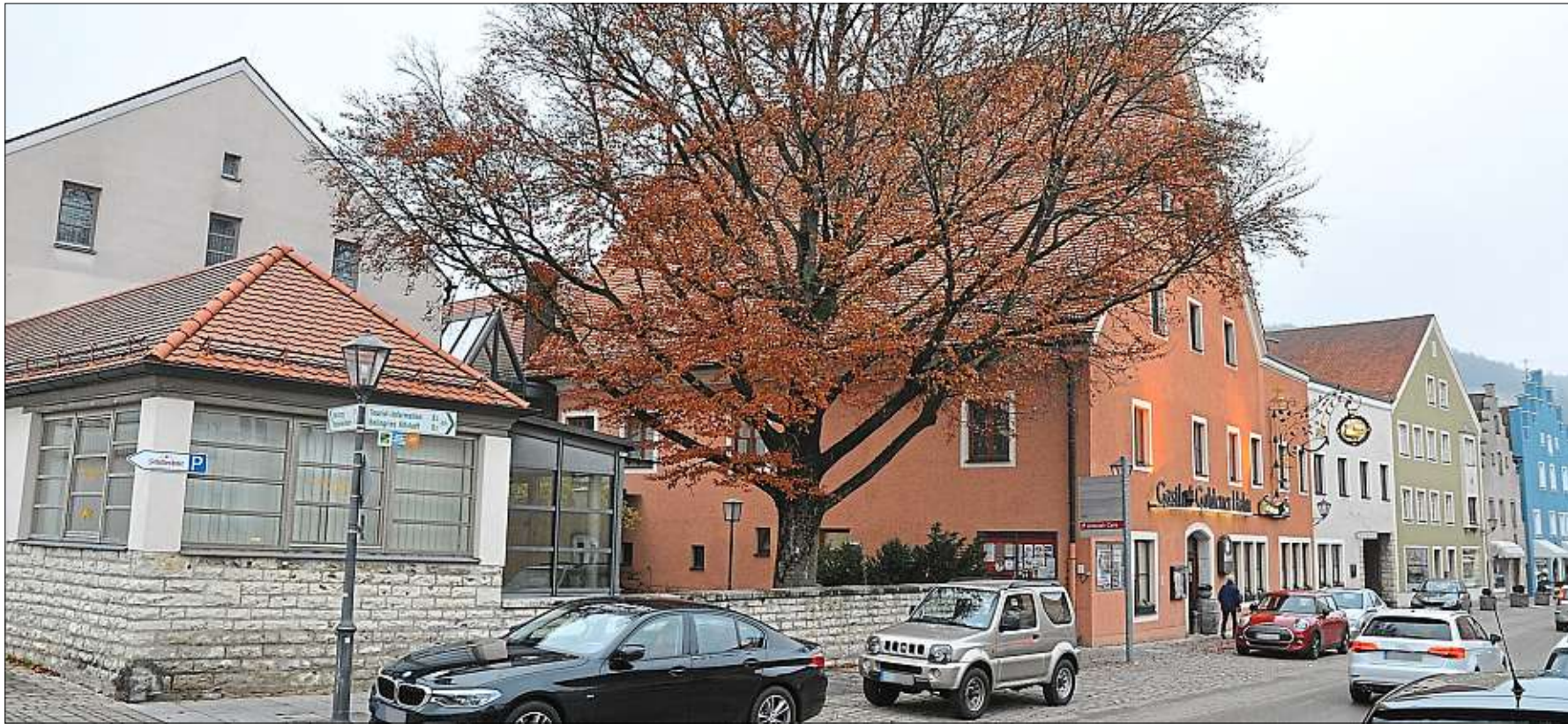
In eine Großbaustelle wird sich auf absehbare Zeit der Gebäude-Komplex Schattenhofer in der oberen Altstadt verwandeln. Die frühere verkehrspädagogische Akademie (links im Bild) soll einem großen Biergarten weichen. Foto: F. Rieger
